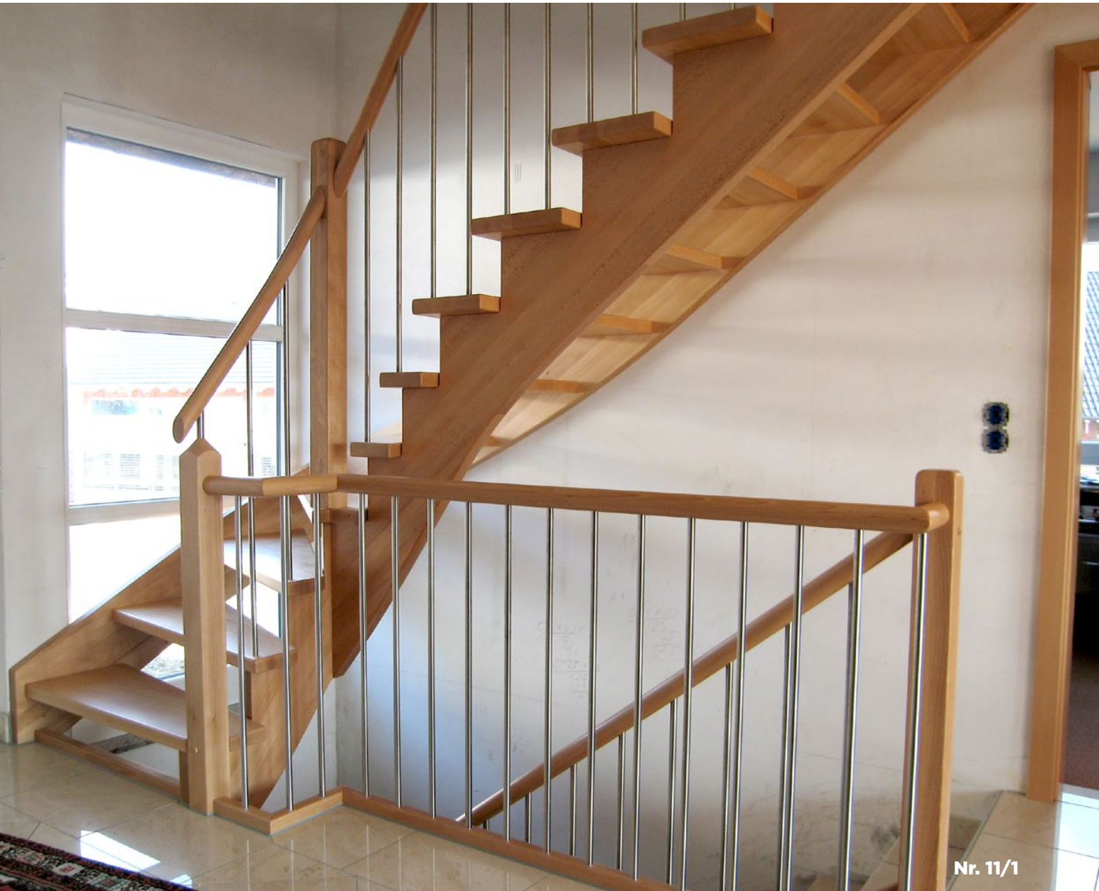
Holzwangentreppe eingestemmt - aufgesattelt mit Rundholzhandlauf.
